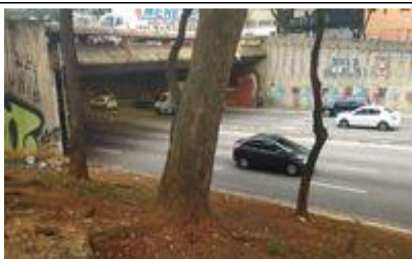
Visada de túnel
