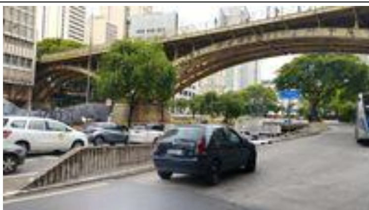
Cruzamento viário (passarela)
