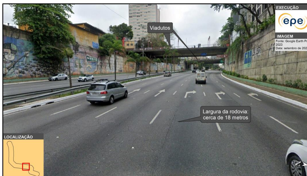
Figura 4 - Avenida Radial Leste Oeste
