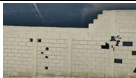
Muro sob viaduto
