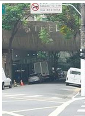
Arruamento sob ponte
