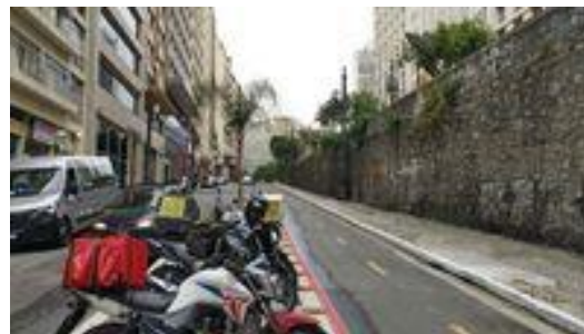
Arruamento adjacente ao talude
