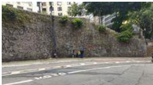
Talude de corte com muro de pedra
